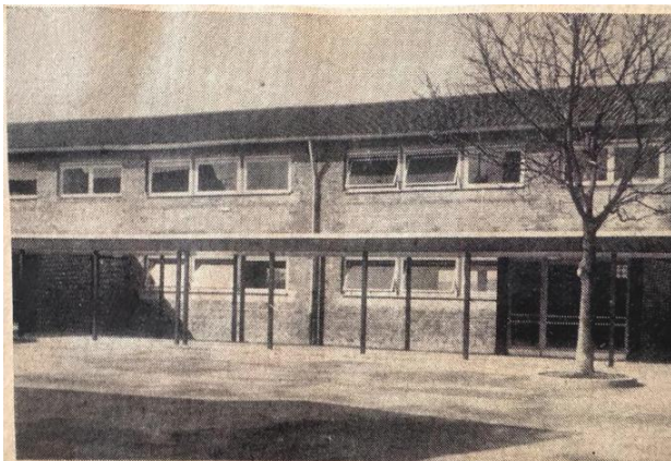
Um den vorderen Schulhof gruppieren sich die drei Trakte der neuen Rauenthaler Volksschule. In der Mitte der Klassentrakt, rechts die Verwaltungsabteilung und links die sanitären Anlagen, alle drei von einer Pausenhalle verbunden.
